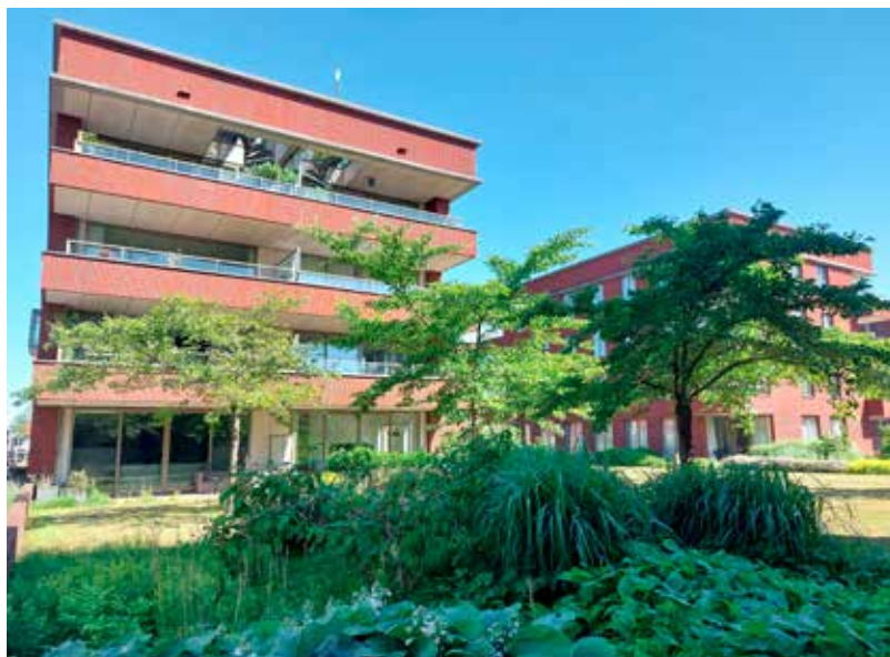
Het appartementencomplex Timmerwerf in Utrecht had de primeur van het systeem. .
